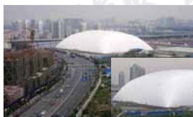
图3 浙江某农药厂污染土壤修复工程封顶复封系统
